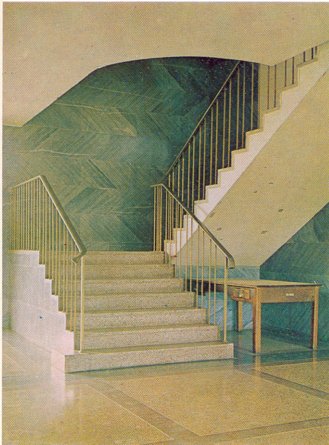
Plaat XIII.—Duifgrys marmmer met onreelmatige strepe soos gebruik vir binneversiering van die Staatshospitaal, Windhoek (lok. 38, voubl. 2).
